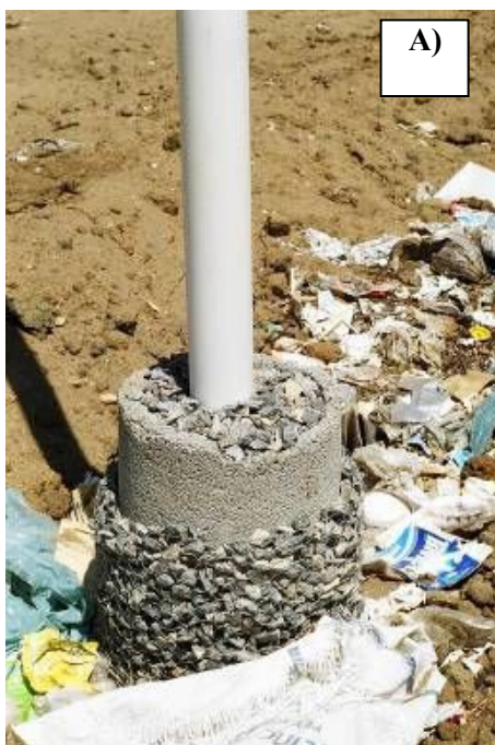
Figura: A) Drenos de gases, B) Aterro Sanitário
